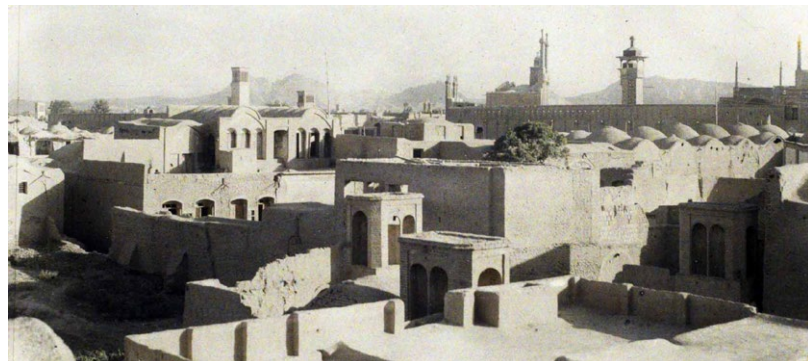
تصویر ۲۱: وجود بادگیرهای بلند و کوتاه در نمای بام شهر قم (Gadmer 1927)
