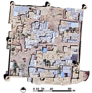
تصویر ۸: تصویر هوایی قلعه صلوات‌آباد (Google Earth 2025)
