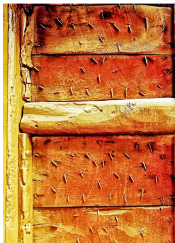
تصویر ۲۷: چگونگی پرچ گل‌میخ از تخته منبت‌کاری بر تخته زیرین در منبر حسینیه چارسوق آران
