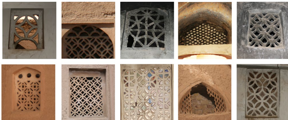
تصویر ۳۳: پنجره‌های مشبک خانه‌ها در قلعه جندق، ۱۳۸۹
