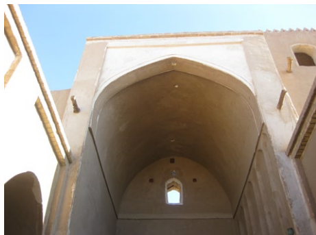
تصویر ۱۳: ایوان جنوبی خانه صفایی، ۱۳۸۹
