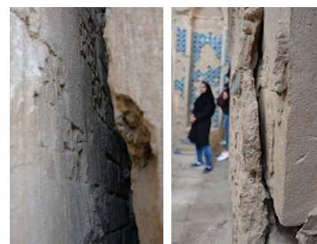
تصویر ۴۶: لایه‌های زیرین تزیینات بنای پیربکران تصویر ۴۷: کشف لایه زیرین تزیینات کتیبه روضه شیخ در پی ترک خوردن کتیبه
