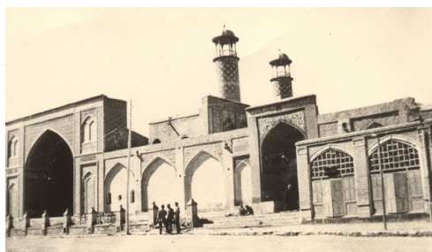
تصویر ۱۳: سامان‌دهی جداره جنوبی بنا پس از احداث خیابان با مرمت ایوان جنوبی و ساخت چند دهنه مغازه و سکوی ورودی (شریعتی)
