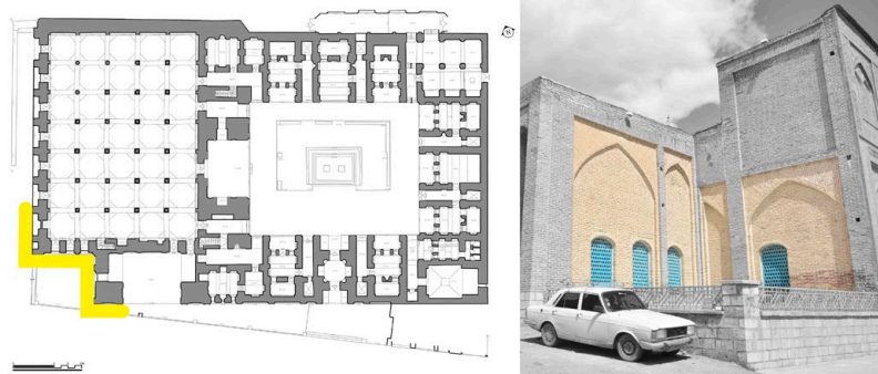
تصویر ۵: پس نشستن دیوار در گوشه جنوب غربی بنا و بی‌نظمی نمای آن
