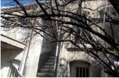
مساحت ۱۶۰ متر مربع، دارای یک ورودی، یک راه ارتباطی با همسایه مجاور در جبهه شرقی، فاقد دالان و پیرنشین و زیرزمین، جبهه شمالی دوطبقه و سایر جبهه‌ها یک طبق.
