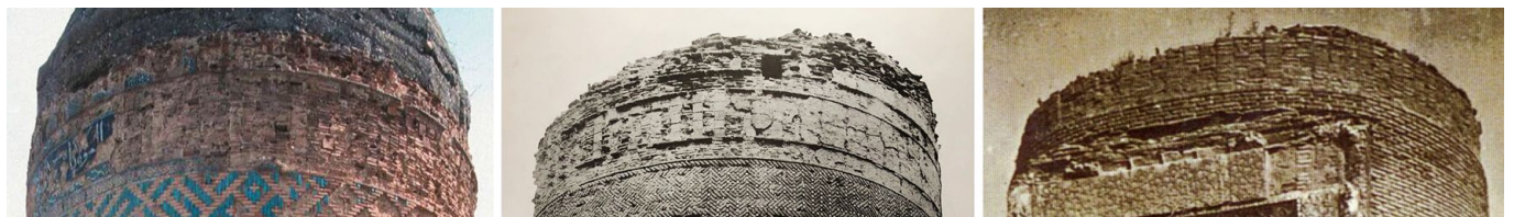
تصویر ۸: چیدمان آجرهای پشت‌کار کتیبه‌ها، به ترتیب از سمت راست: سه‌گنبد (آرشیو بنیاد ایران‌شناسی استان آذربایجان غربی)، شیخ حیدر (پوپ ۱۹۶۹، ۳۴۳) و بردع توربسی (Tavakoli and Cinmarasi 2020, 263)
