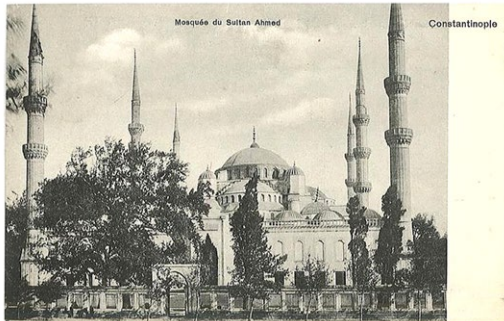
تصویر ۳: عکس مسجد سلطان احمد (Archnet). گنبد با پشت‌بندهایی به صورت نیم‌گنبد برای مهار رانش اجرا شده است.
