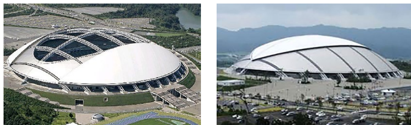
تصویر ۵: نمونه سقف باز و بسته‌شونده با مکانیزم لغزشی، راست: سقف استادیوم ورزشی اویتا در حالت بسته، چپ: سقف این مجموعه در حالت باز (URL 2)
