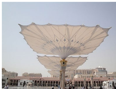
تصویر ۱۲: نمونه سقف باز و بسته‌شونده با مکانیزم چتری، راست: سایه‌بان‌های مسجدالحرام در حالت بسته، چپ: سایه‌بان‌های این مجموعه در حالت باز (URL 5)
