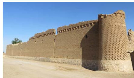
تصویر ۱۷: برج شمال غربی رباط سپنج و نمایی از حصار شمالی
