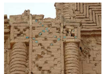
تصویر ۱۶: استفاده از کاشی به شکل نگینی در میان سطوح آجرکاری در ضلع ورودی رباط سپنج. بخش زیادی از کاشی‌ها فروریخته‌اند.
