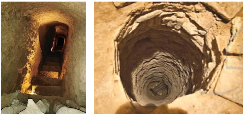
تصاویر ۱۶ و ۱۷: از راست به چپ؛ چاه فریب در مجموعه اویی (وفایی و هاشمی فشارکی ۱۳۹۱) راه گریز از مجموعه اویی به قنات فیض‌آباد
