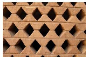
اجرای نقوش خوون چینی، مشبک‌سازی
