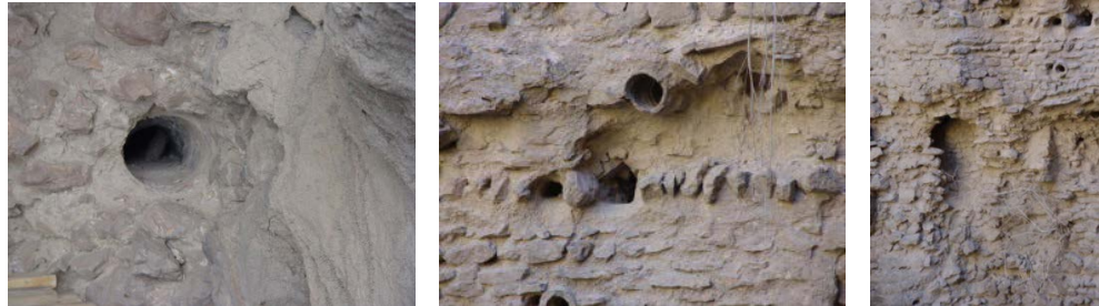
تصویر ۷: مجاری تخلیه سیلاب در بدنه سد
