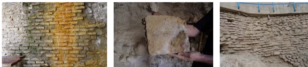
تصویر ۱۱: استفاده از آجر در قسمت‌هایی از سازه سد
