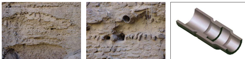
تصویر ۱۲: راست: برش طولی از حجم تنبوشه‌های سفالی و نحوه اتصال آن‌ها با یکدیگر؛ وسط و چپ: قرارگیری تنبوشه‌ها در ترازهای مختلف بدنه سد
