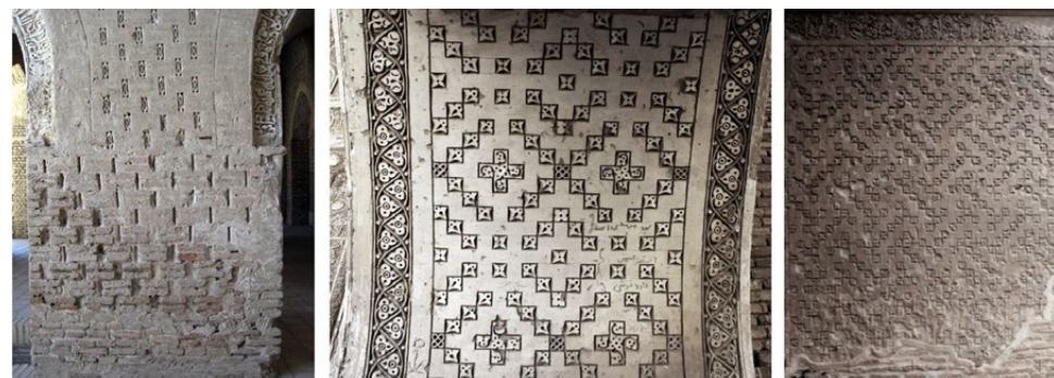
تصویر ۲۵: آجرکاری دوتایی با بند مهری و آرایه‌های گچ‌بری با نقوش هندسی مسجدجامع فرومد که در مشابهت آشکار با رباط شرف و رباط ماهی است.
