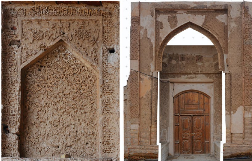
تصویر ۱۸: راست: تصویر تخت ایوان ورودی که با تزیینات آجری و گچ‌بری‌های نفیس پرداخت شده است؛ چپ: تزیینات گچ‌بری قاب‌نماهای طرفین ایوان شمالی که با کتیبه خط کوفی و اسلیمی‌های ظریف پوشیده شده است. این آثار متعلق به مداخلات دوره علاءالدین محمد است (عمارت خورشید ۱۳۹۰).
