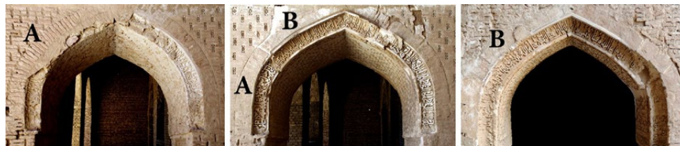
پایه شرقی (دهانه شمالی)
