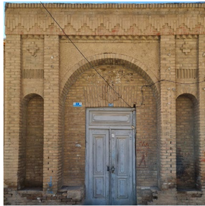
تصویر ۱۲: تزیینات آجرکاری سردر خانه قائمی‌ها
