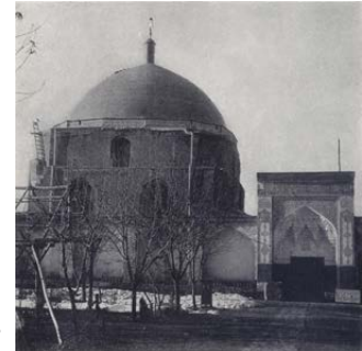
تصویر ۲۴: گنبد کاشی‌کاری شده در دوره پهلوی (Wilson 1937, 39)؛ ب. گنبد با پوشش ورق گالوانیزه (شیروانی) آرشیو اداره کل میراث فرهنگی، گردشگری و صنایع‌دستی استان آذربایجان غربی؛ ج. وضعیت موجود گنبد با پوشش آجری
