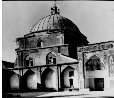
تصویر ۲۴: گنبد کاشی‌کاری شده در دوره پهلوی (Wilson 1937, 39)؛ ب. گنبد با پوشش ورق گالوانیزه (شیروانی) آرشیو اداره کل میراث فرهنگی، گردشگری و صنایع‌دستی استان آذربایجان غربی؛ ج. وضعیت موجود گنبد با پوشش آجری
