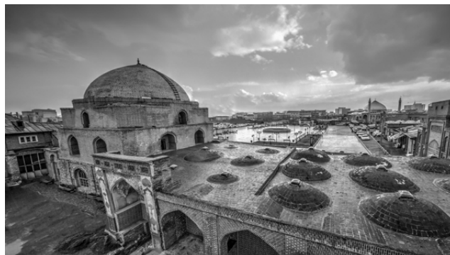
تصویر ۱۲: تفاوت موجود در ساختار پوشش سه ناو فرش انداز در ضلع غربی گنبدخانه
