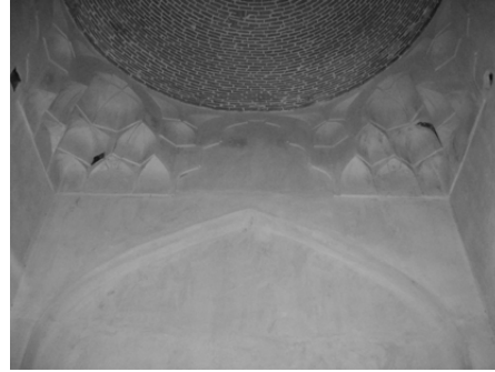
تصویر ۷: الف. گوشه‌سازی گنبدخانه مسجدجامع ارومیه؛ ب. گوشه‌سازی مسجدجامع مرند؛ ج. گوشه‌سازی سه‌گنبد ارومیه؛ د. گوشه‌سازی گنبد سرخ مراغه
