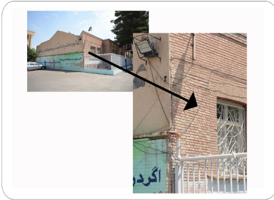
تصویر ۸: عکس تفاوت بافت آجری در محل پنجره مسدود شده در جوار ورودی نمای جنوبی
