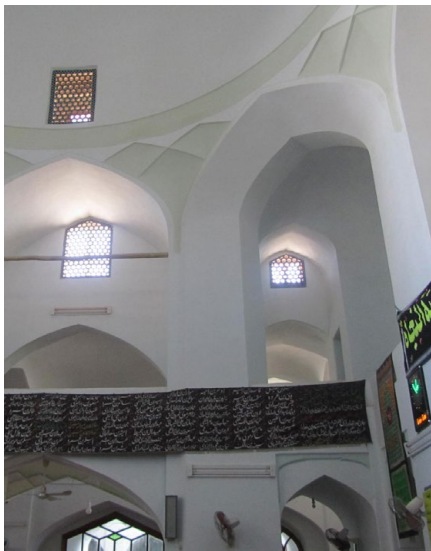
تصویر ۹: تشابه ساخت در ناحیه بَشَن و چپیره‌سازی زیر گنبدخانه مسجد کبود تبریز و مسجد شاه ولی تفت
