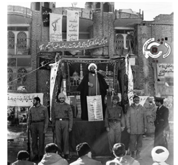
تصویر ۱۴: عکسی از نمای در حال بازسازی مسجد آقا ضیاءالدین در پس‌زمینه (جمال‌زاده)
