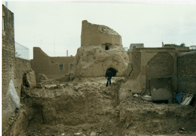
تصویر ۱۴: وضعیت نمای غربی بنای گنبددار در سال ۱۳۸۲ و پیش از ساختن قطعه زمین غربی بنا. در منتهی‌الیه سمت راست تصویر ورودی دخمه قابل مشاهده است. با ساختن این قطعه و تجاوز آن به عرصه باقی‌مانده بنای گنبددار، از وضعیت دخمه و ورودی آن اطلاعی در دست نیست (میراث فرهنگی کاشان ۱۳۸۲).
