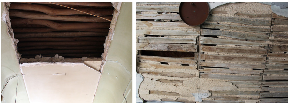
تصویر ۱۱: سقف کاذب چوبی یا آجری برای پوشش سقف تیرپوش چوبی با گچ در راهروهای خانه‌های شماره ۱ و ۱۰
