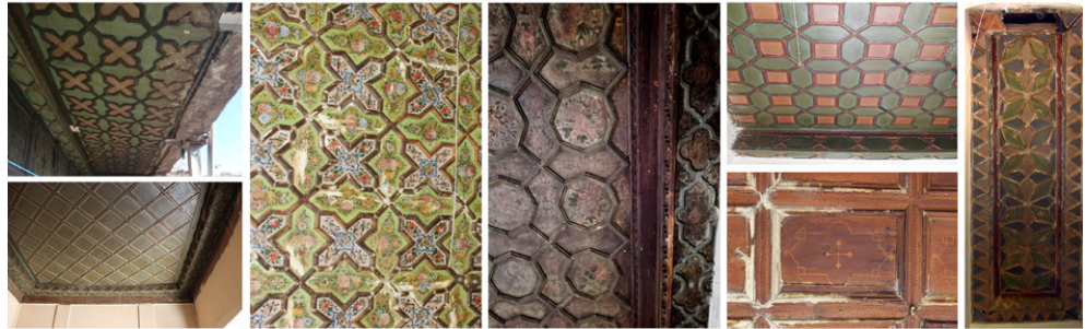
تصویر ۴: تصاویری از سقف‌های تیر چوبی در خانه‌های شماره ۲، ۱۲، ۱۳ و ۱۴ که به وسیله پوشش کاذب مشبک چوبی پوشیده و تزیین شده‌اند.
