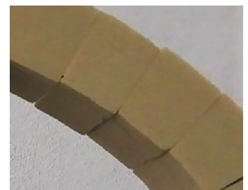
تصویر ۱۸: لبه‌های قطعات قوس دقیق نیستند و به داخل خم شده‌اند.
