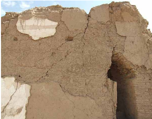
تصویر ۱۲: لایه‌های متعدد اندودکاری و بقایای طاق فروریخته شبستان روی بدنه داخلی سردر مشهود است.
