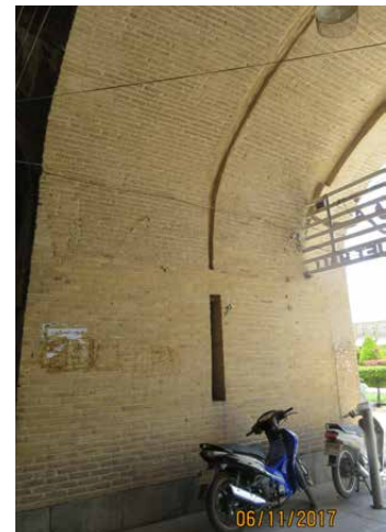
تصویر ۶: دهانهٔ شاهد به عمق ۲۰ سانتی‌متر بین جرز اول و دوم در محل توسعهٔ بدنهٔ میدان در یکی از دهانه‌های بدنهٔ شرقی
