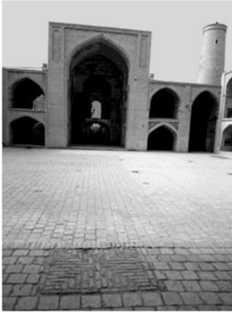
تصویر ۱۷: مسجد جامع اردستان. ردّ ستون مسجد اولیه، واقع در کف میان ایوان شرقی، در مرمت مشخص شده است.
