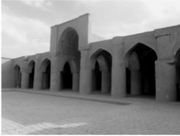
تصویر ۱۳: سوی قبله تاریخانه دامغان پس از تعمیرات دهه ۱۳۳۰ش دچار تغییر در طرح اولیه شده است و چنان به نظر می‌رسد که ایوان دارد. طاق ناو میانی اصالت خود را حفظ کرده است.
