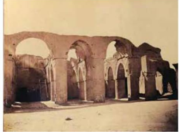
تصویر ۱۲: سوی قبله تاریخانه دامغان در ۱۹۱۳م/۱۲۹۱ش. قوس‌های رو به صحن و طاق شبستان در یک تراز قرار دارد (سمسار و سرائیان ۱۳۸۲: ۲۹۴).
