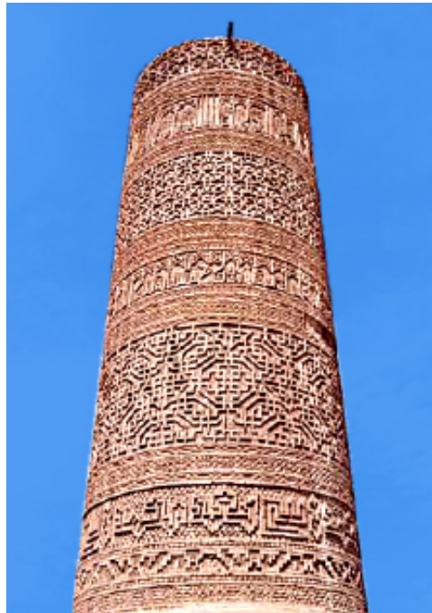
تصویر ۳: ۱. نقوش آجری بی‌مانند ۲. گره‌های آجری کمربندی ۳. سه کتیبه خط کوفی بی‌همتای منار مسجد جامع ساوه ۴. خط کوفی بنایی در کتیبه پایین برج، (دوره سلجوقی)
