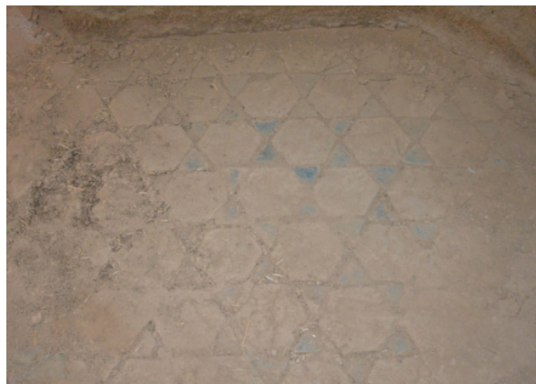
تصویر ۱۸: ترکیب آجر و کاشی جهت پوشش کف در خانه برونی
