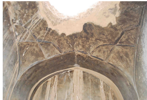
تصویر ۲۴: پوشش کاربندی خانه محمد جوکار در روستای خوی‌دک نقشه ۷: جانمایی استفاده از کاربندی جهت پوشش برخی از فضاها، خانه بابایی (خادم‌زاده ۱۳۸۷، ۲۰۹)
