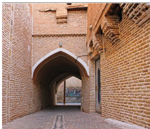
تصویر ۲-۷: تونجه (نمونه‌ای از نحوه افزایش سطح بنا در طبقه اول با استفاده از پله‌های آجر از سمت معبر در بافت دزفول).
