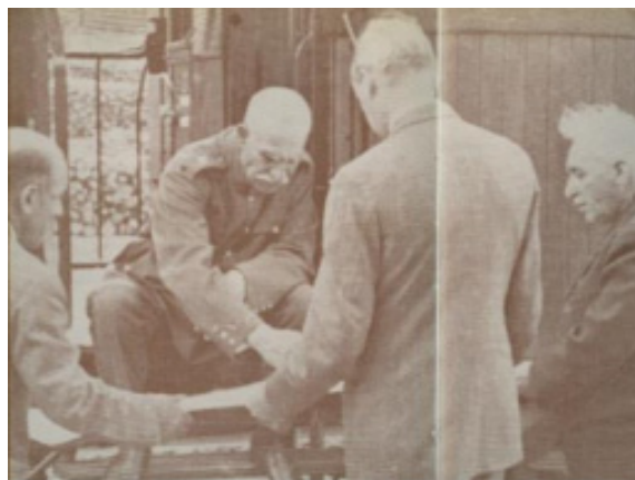
تصویر ۹: رضاشاه در حال بازدید از کارهای ساختمانی (رجبی ۲۵۳۵ [۱۳۵۵]، ۶۴-۶۵)
