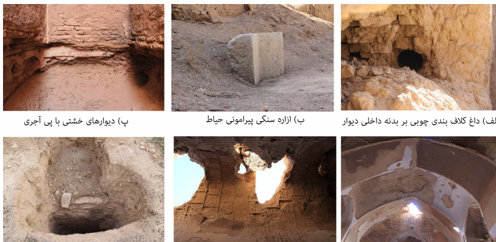
تصویر ۱۶: انواع مصالح به‌کاررفته در مدرسه جعفرآباد
