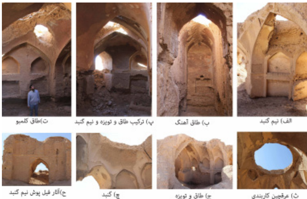
تصویر ۱۵: انواع پوشش‌های به‌کاررفته در مدرسه جعفرآباد
