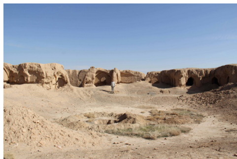
تصویر ۱۰: مدرسه جعفرآباد، نمای شرقی حیاط
