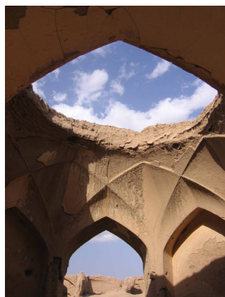
تصویر ۷: مدرسه جعفرآباد، فضای داخلی هشتی
