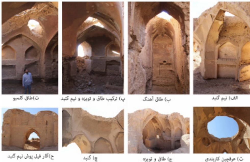
تصویر ۱۵: انواع پوشش‌های به‌کاررفته در مدرسه جعفرآباد
