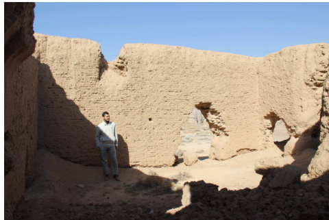
تصویر ۱۴: مدرسه جغرافیاد، فضای داخلی حیاط غربی دید از جنوب غربی
