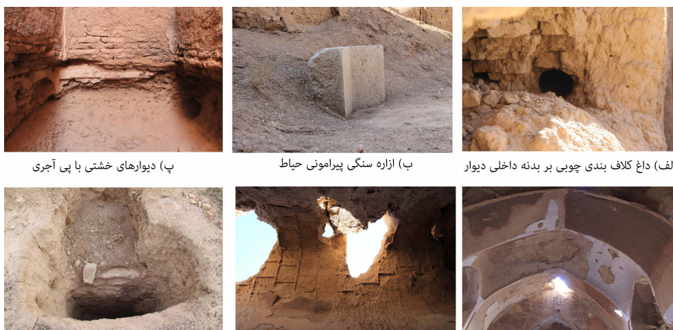
تصویر ۱۶: انواع مصالح به‌کاررفته در مدرسه جعفرآباد
