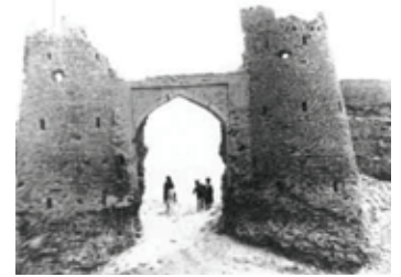
تصویر (۵): دروازه ربع رشیدی، در دوره قاجاریه، آرشيو مجتمع ربع رشیدی
